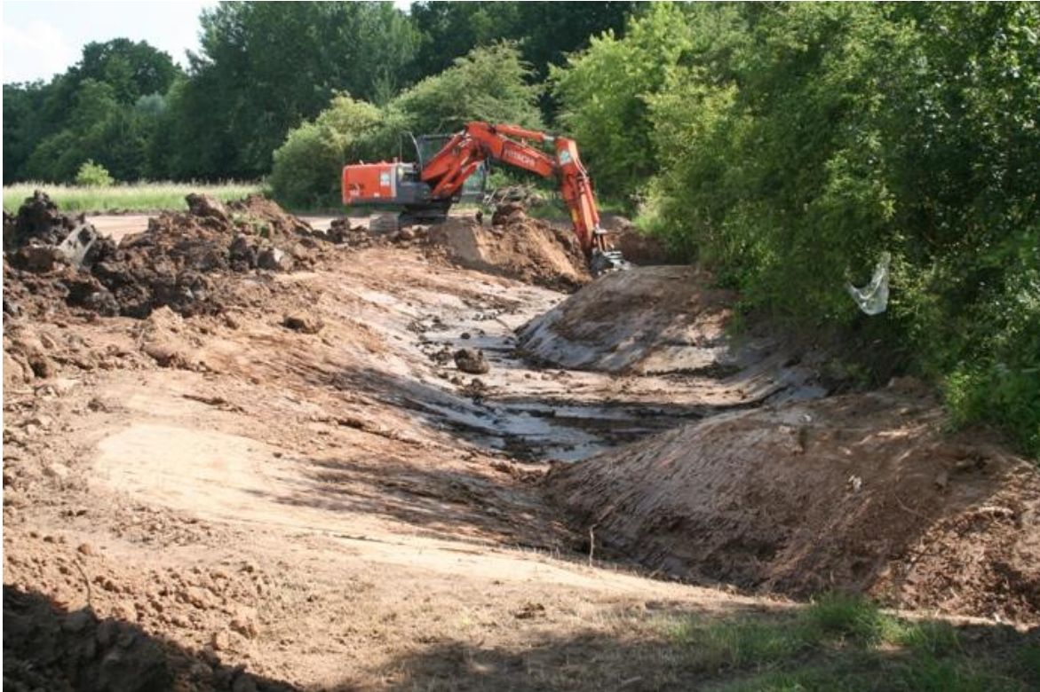
Oben: Erdarbeiten 29.06.2015: der Gewässerverlauf an der Warft 2 wird ausgehoben
